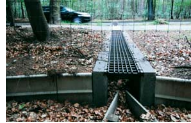
Şekil 9. Nesli tehlike altında bulunan sürüngenler için kullanılan özel yapım geçit tipi (FHWA, 2014)
